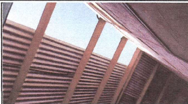
Foto 2: Sustitución de lámina, por lámina troquelada aluzinc calibre 26 Sustitución de capote de lámina para lámina acanalada Sustitución de elementos de fijación
